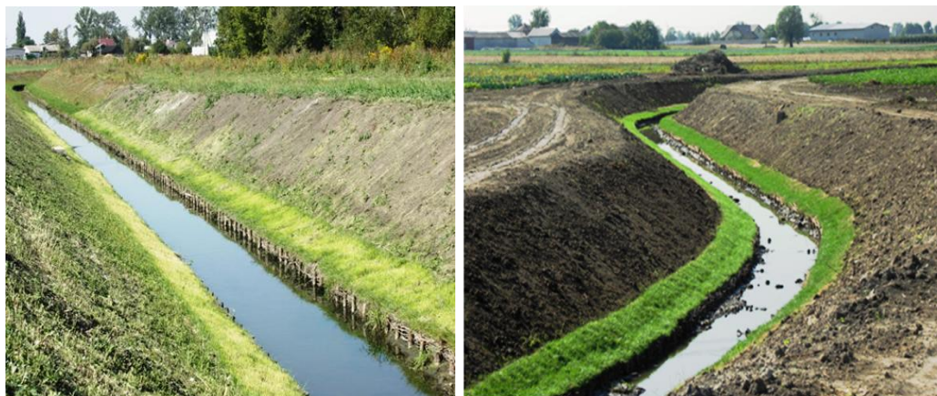
Ilustracja 69. Przykładowe umocnienia rowów materiałami ekologicznymi: darniną oraz płotkiem i kiszką faszynową Fot. T. Kowalik
