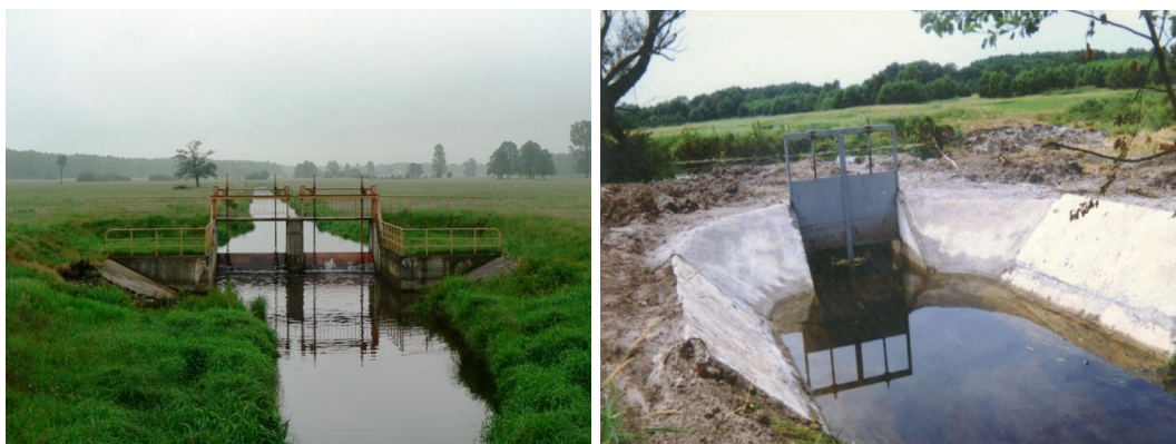
Ilustracja 76. Przykład urządzeń do nawadniania podsiąkowego: jaz na rzece oraz zastawka piętrząca
