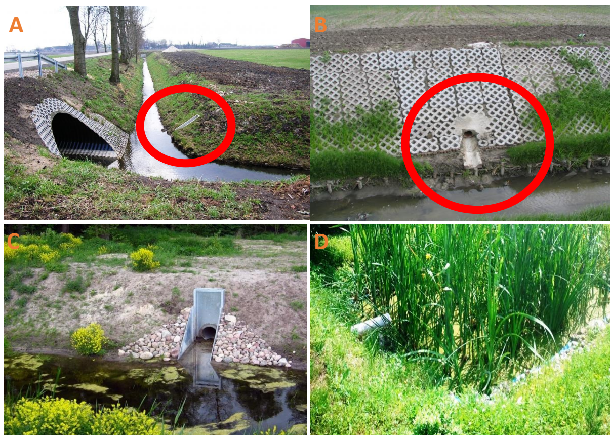
Ilustracja 29. Sposoby odprowadzenia wody z sieci drenarskiej: A i B – bezpośrednio do rowów melioracyjnych, C i D – bezpośrednio do małych zbiorników (biofiltrów)
