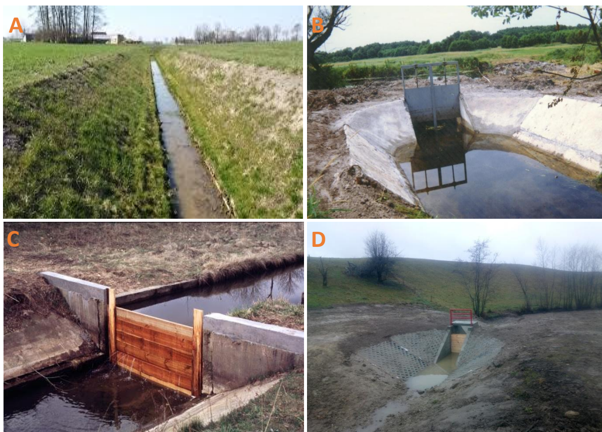
Ilustracja 30. Urządzenia i budowle wodno-melioracyjne: A – rów odwadniający bez budowli piętrzących, C i D – dwa różne typy zastawek piętrzących na rowach melioracyjnych
