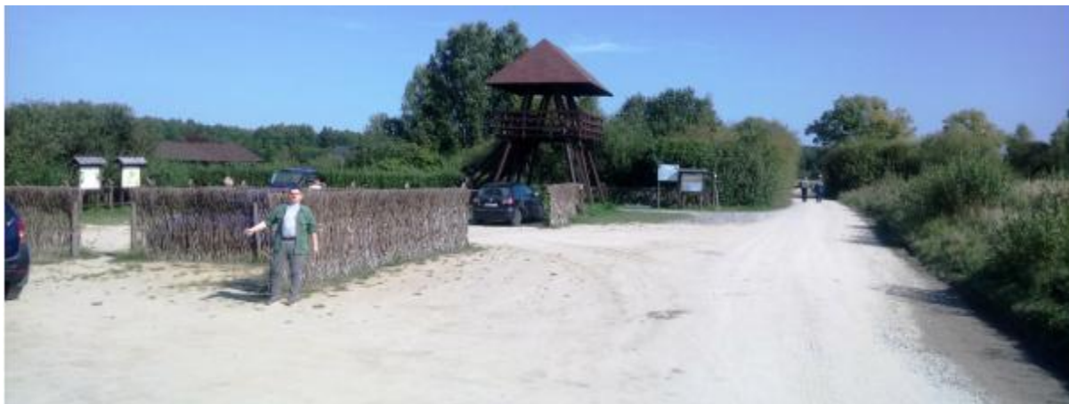
Ilustracja 45. Droga wyremontowana w ramach prac scaleniowych w miejscowości Zastawie umożliwiającą dotarcie do Ścieżki Dydaktycznej Czachary w Poleskim Parku Narodowym
