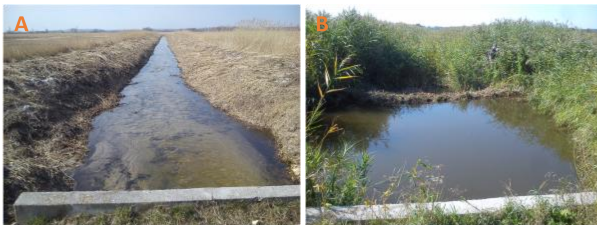
Ilustracja 23. Hajdaszek po oczyszczeniu i ponownym zarośnięciu roślinnością szuwarową: A – stan na dzień 17. marca 2020 r., B – stan na dzień 15. września 2020 r.
