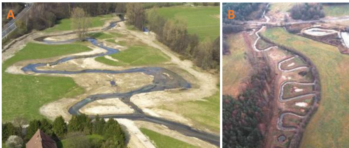
Ilustracja 12. Przykłady zabiegów renaturyzacyjnych wykonanych poprzez antropogeniczne przekształcenie trasy regulowanego cieków – obszary A i B – meandryzacja cieków w przestrzeni dostępnej dzięki wykonaniu prac scaleniowych
