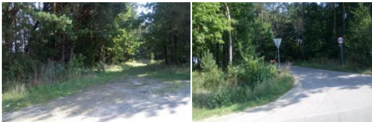
Ilustracja 87. Efekt poprawy bezpieczeństwa w ruchu drogowym dzięki przebudowie skrzyżowania drogi transportu rolnego z drogą gminną na obiekcie Andrzejów-Wincencin-Zastawie
