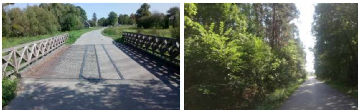
Ilustracja 49. Elementy infrastruktury drogowej wykonane w ramach zagospodarowania poscaleniowego na obiekcie Andrzejów-Wincencin-Zastawie
