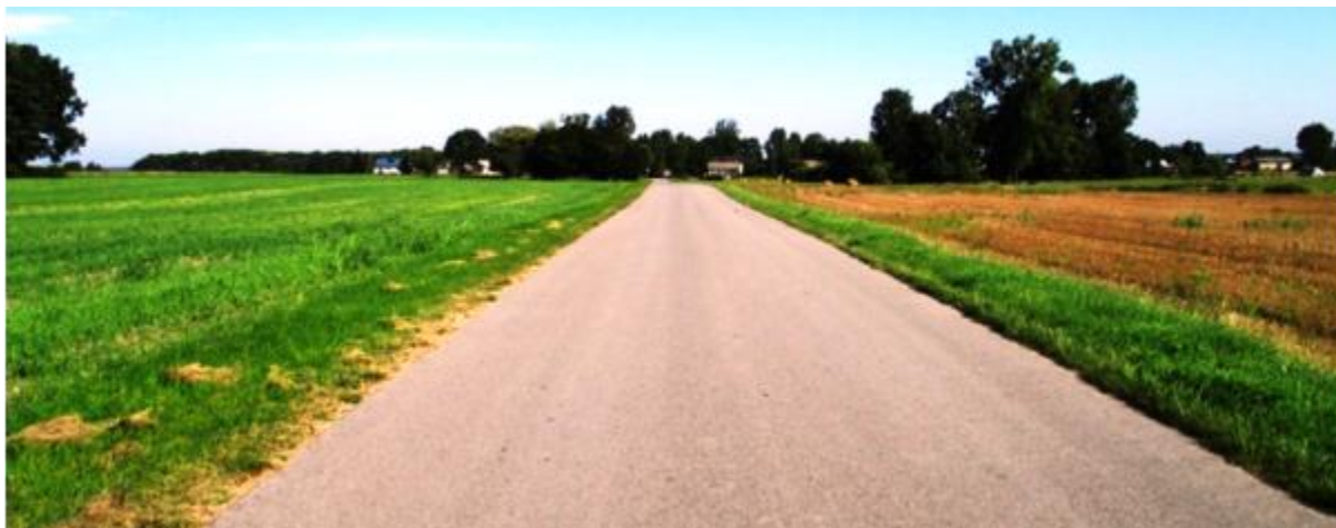
Ilustracja 80. Droga z wytyczonym pasem ochronnym wyremontowana w ramach zagospodarowania poscaleniowego w Andrzejowie
