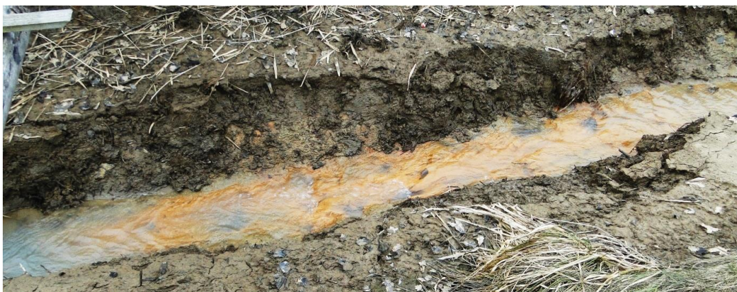
Rysunek 18. Po lewej i u dołu ciek melioracyjny z wyraźnymi śladami osadów chemicznych, po prawej u góry miejsce ujścia zanieczyszczonej wody z kilku zbieraczy do rowu melioracyjnego
