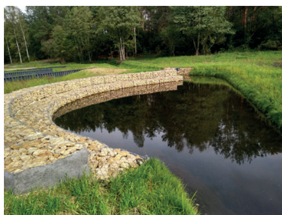
Ryc. 7. Sekwencyjny system sedymentacyjno-biofiltracyjny służący poprawie jakości wód cieką przechodzącego przez tereny rolnicze i zasilającego zbiornik rekreacyjny; wybudowany na cieku spod Ochotnika przez Urząd Miasta Przedborza
