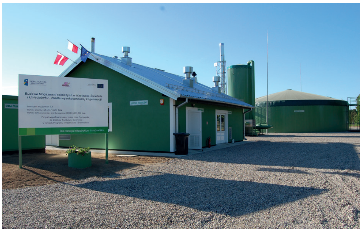
Ryc. 5. Biogazownia rolnicza w Naclawiu o mocy 625 kW
