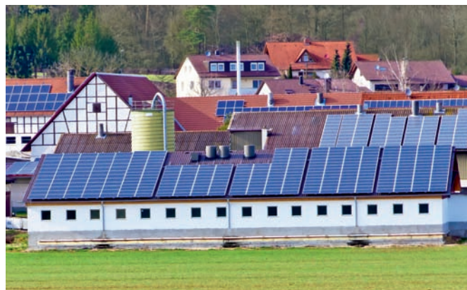
Fot. 1.9. Panele fotowoltaiczne na dachu budynku inwentarskiego (fot. Adobe Stock)
