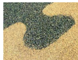
Fot. 3.5. Przykłady nawierzchni przepuszczalnych: (A) kraty ażurowe, (B) mieszanki mineralno-żywiczne
