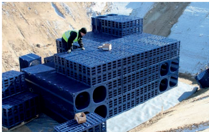
Fot. 3.12. Przykład montowanej skrzyni retencyjno-rozsączającej
