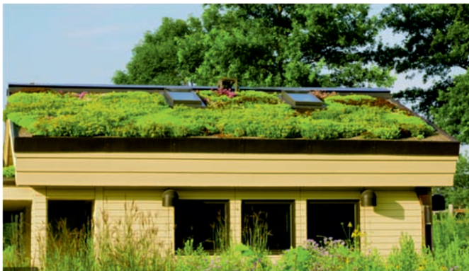
Fot. 3.6. Przykłady zielonych dachów
