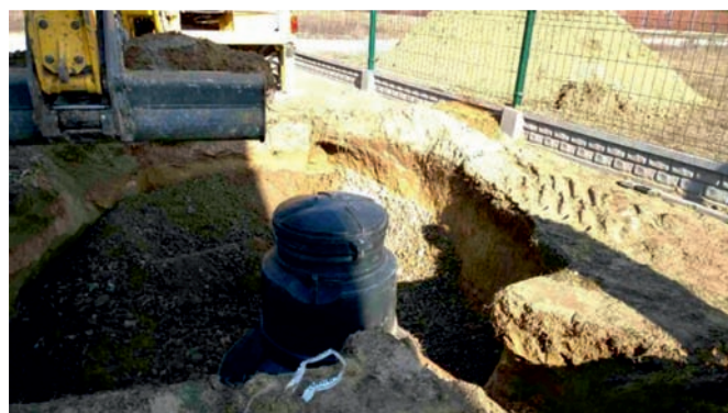
Fot. 3.11. Przykład studni chłonnej
