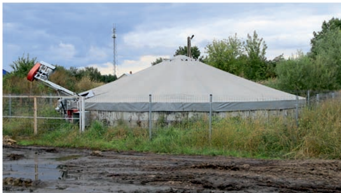
Fot. 1.2. Zadaszony zbiornik na gnojowicę z widocznym mieszadłem (fot. Ewa Witkowska Made In Media)
