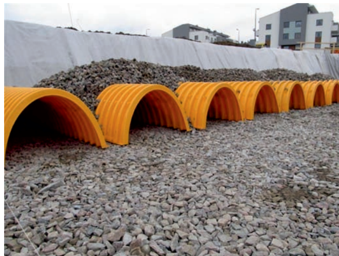
Fot. 3.13. Przykład komór drenażowych
