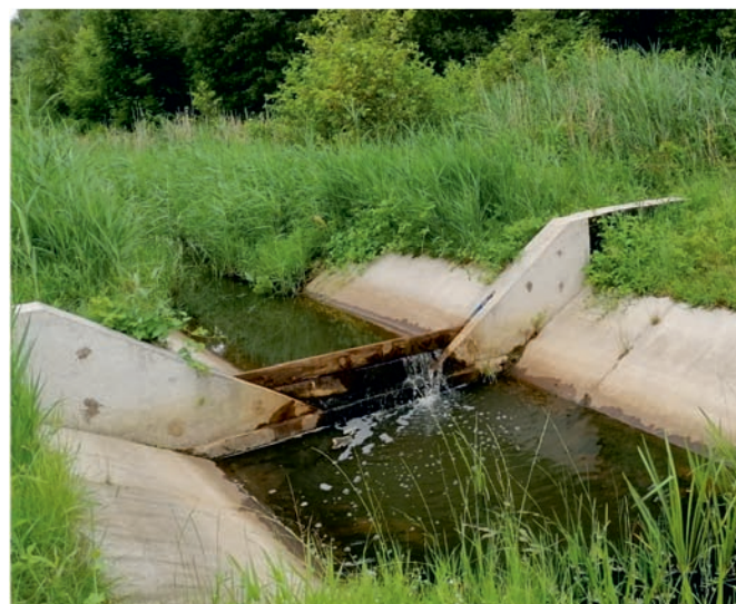
Fot. 1.11. Działania z zakresu retencji z wykorzystaniem systemów melioracyjnych – piętrzenie wody za pomocą zastawek (fot. K. Izydorczyk)
